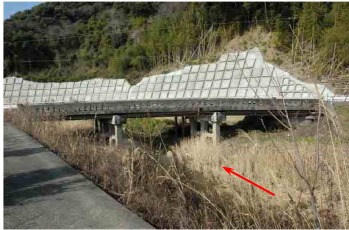
泉養寺橋 (4.62K 付近)
