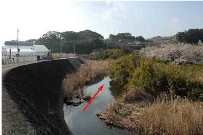
3. 4K 付近左岸より
