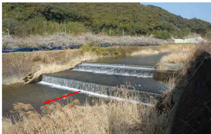
大井頭首工 (4.35K 付近)
