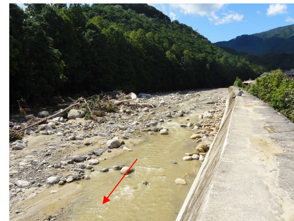
長谷川合流点上流
