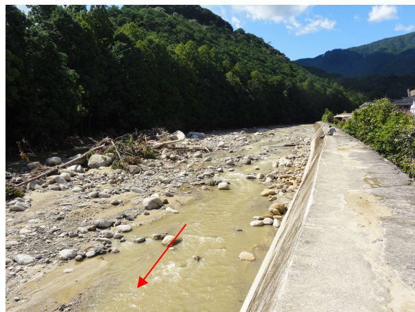
長谷川合流点上流
