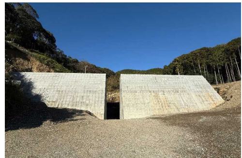
砂防堰堤の新設
