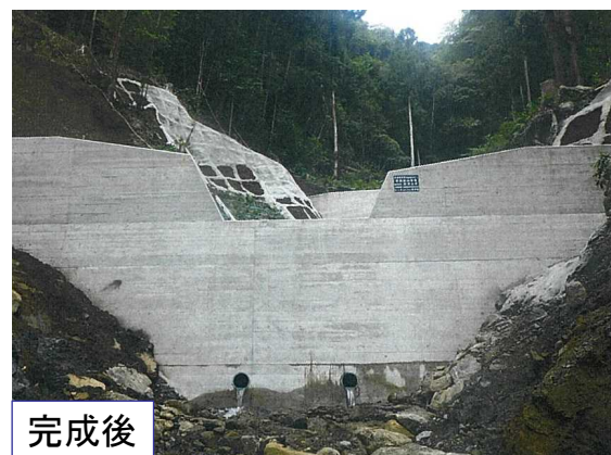
溪間工により復旧
