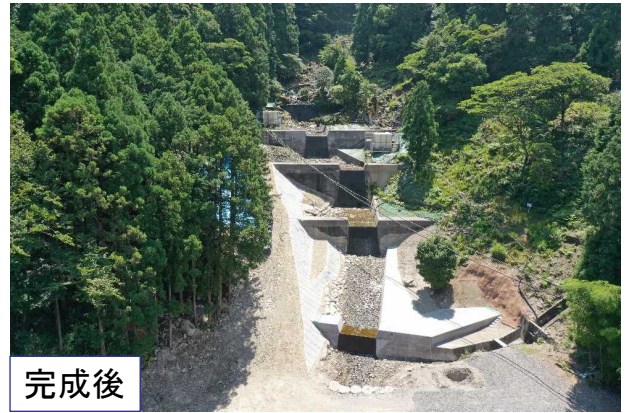
溪間工により復旧
