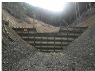
溪間工事の例
