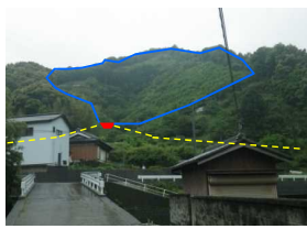
砂防堰堤の新設
