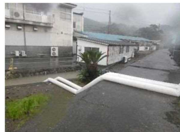
島田地区 水路での排水状況
