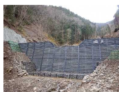
国有林直轄治山事業における谷止工 (有田川町 津俣国有林)
