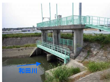
写真 1 - 1 和田川樋門 西川2.8k付近
