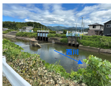
写真 1 - 2 東裏川千貫樋門 西川3.3k付近
