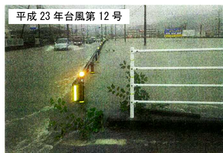
荊木地区（国道42号）
