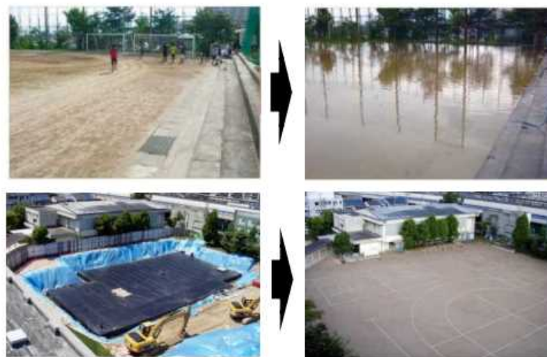
【雨水貯留浸透施設】
