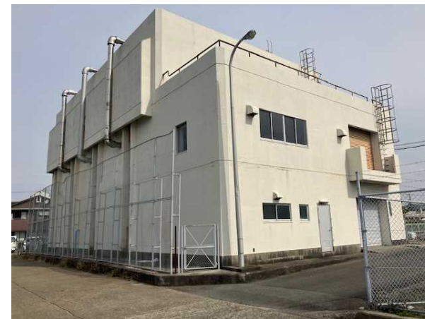
【上川ポンプ場】
