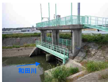
写真 1 - 1 和田川樋門 西川2.8k付近
