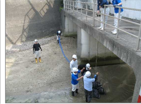
【ポンプを設置する訓練】
