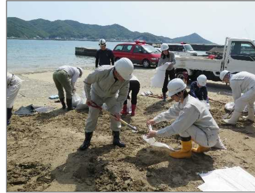
【二人一組で土のうを作成】
