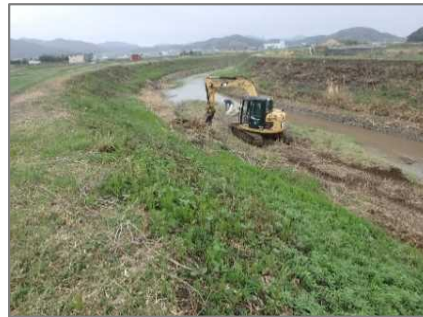
【志賀川 河道掘削】
