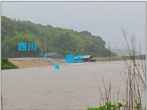
【③西川 越水の様子 志賀川合流部下流】
