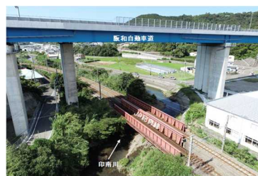
図 1-2 印南川・阪和自動車道付近
