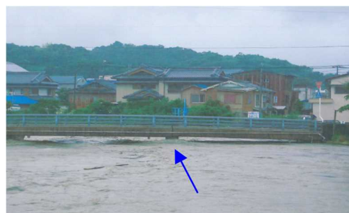
平成18年 八幡橋 (0.7k 付近)
