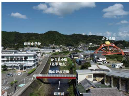
印南川基準地点(1.0k)付近
