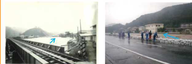
昭和37年7月 JR周参見川橋りょう付近
