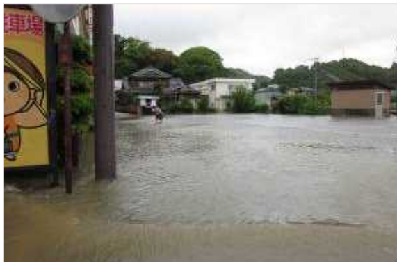
道成寺駐車場の浸水状況
