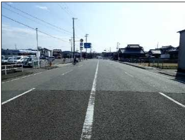
放水路整備予定箇所 (県道御坊停車場線)
