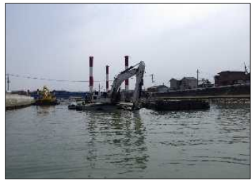
河道掘削状況
