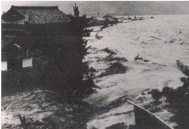
現 野口橋より下流付近（右岸側）
