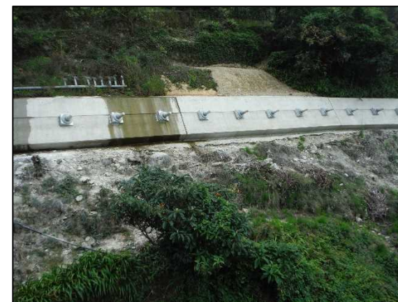
地すべり対策施設の整備
