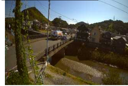
亀の川 羽鳥橋(下流)
