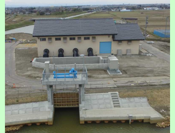
排水機場全景
