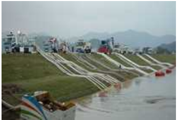
排水ポンプ車による緊急排水
