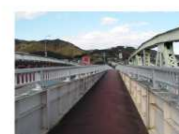
渡河部の歩道橋 新宮市側より紀宝町を望む
