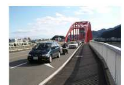
新熊野大橋の歩道設置状況(片側) 紀宝町側より新宮市を望む
