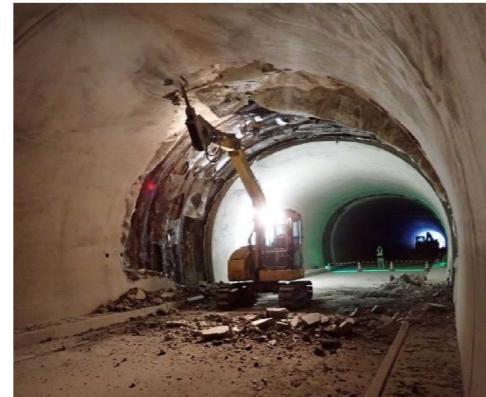
図-3.1 覆工コンクリート取壊し状況
