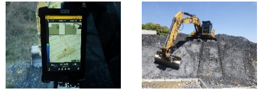
ICTを活用した工事の状況
