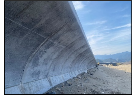
津波避難困難地域解消のための整備 （那智勝浦海岸）
