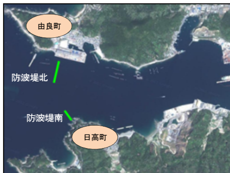
防波堤整備（由良港）
