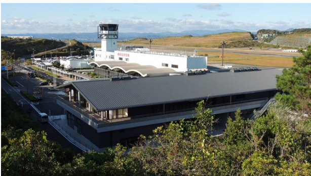
国際線ターミナルビル
