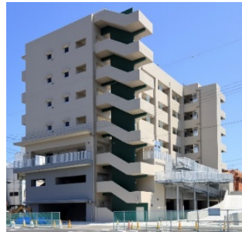
県営住宅串本団地（2024年5月竣工）
