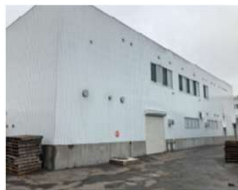
加工場の新設・改修
