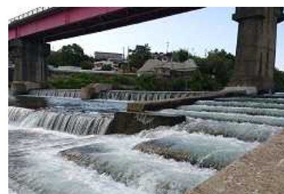
頭首工に設置された魚道
