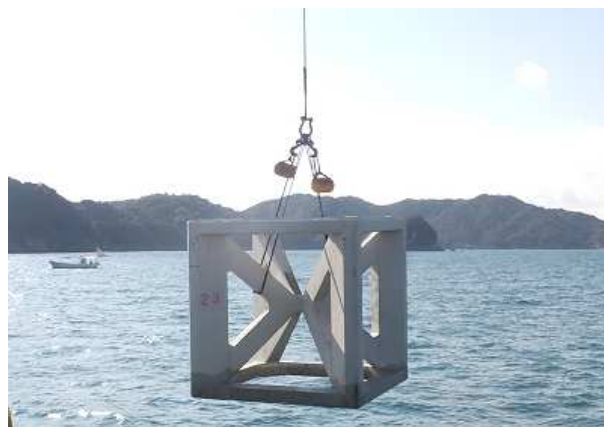
マダイの魚礁漁場造成 (コンクリート製魚礁設置)
