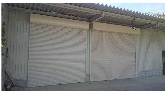
改築した倉庫
