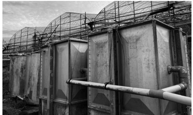
ハウスからの雨水の貯水タンク
