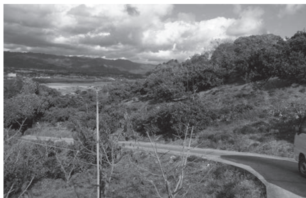
園内道とスプリンクラを設置
