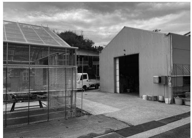
ハウスに隣接した倉庫
