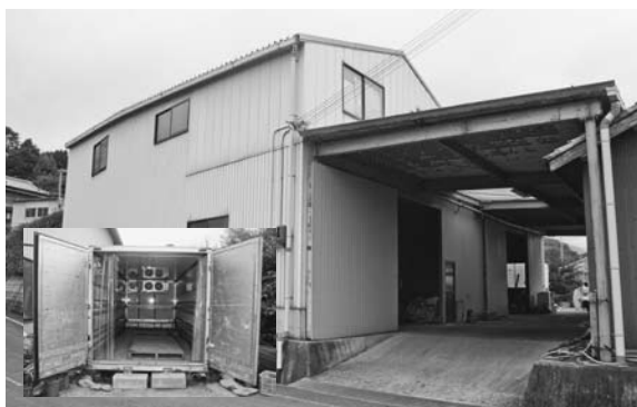
大型倉庫と保冷庫
