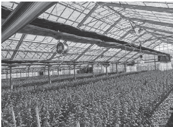
写真1 多層断熱被覆資材を設置したハウス
