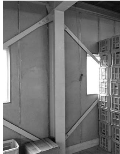
鉄骨倉庫内側の土壁
