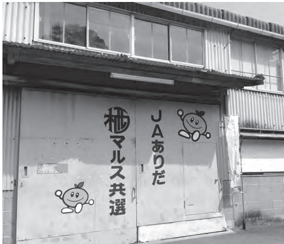
共撰施設の外観
