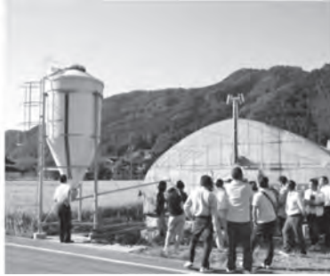
ハウス全景 （ハウスは単棟、燃料のペレットはサイロ（容量 3t）からスクリュウ方式で自動供給）
