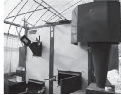
ペレットボイラー （右上から燃料供給、右下扉から灰取り出し）
