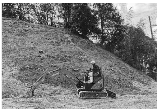
小型重機による抜根作業
