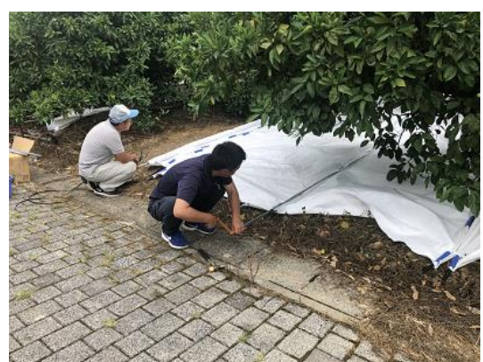
敷設後（巻上げ装置）
