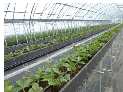
耐風性ハウス・高設栽培施設
