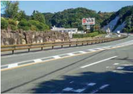
白浜町内に設置された木製ガードレール
