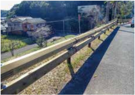
白浜町内に設置された木製ガードレール
