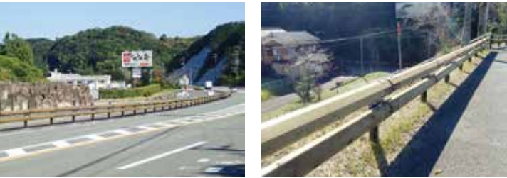
白浜町内に設置された木製ガードレール
