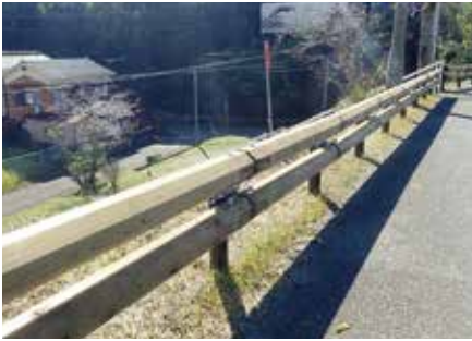
白浜町内に設置された木製ガードレール
