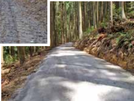
カマタSP® 舗装後
