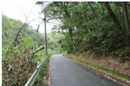
倒木により、道路遮断や電線の切断(ライフラインへの影響)
