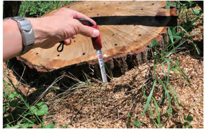
伐採に際し、伐根は地際から10cm以下となるように切断する
