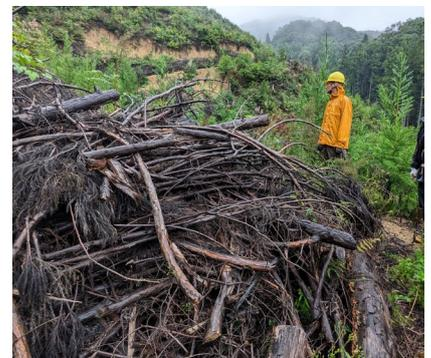
枝葉を作業道の上に集積し、路面を保護
