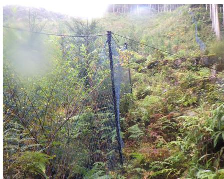
獣害防護柵のセパレートタイプ支柱
