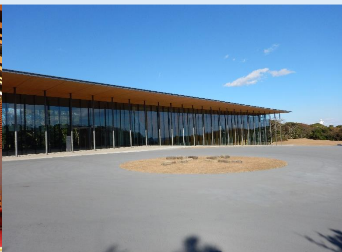
御坊市 御坊市新庁舎
