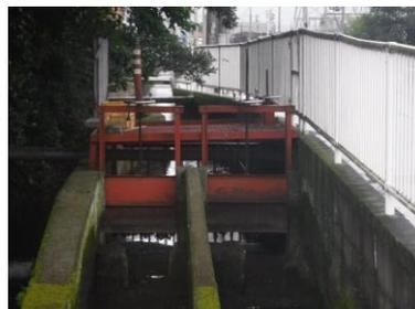
ゲートの電動化
