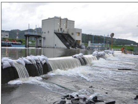
H23.9.1～4 台風12号 排水機での排水が追いつかず、 道路へ越水した排水路（紀の川市）
