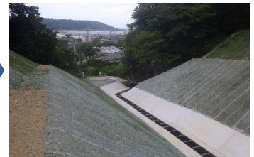
堤体をV字形にカットすることで貯水しなくする廃止工法
