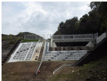
《部分改修》 （取水施設・緊急放流施設整備）
