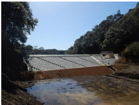
老朽化したため池の改修
