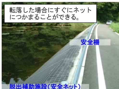
写真 15：安全ネットの設置
