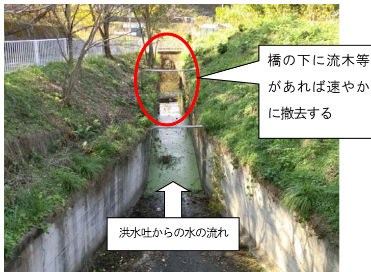
写真8：洪水吐下流水路の例
