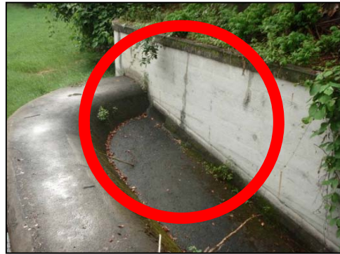
写真9：洪水吐流入部
