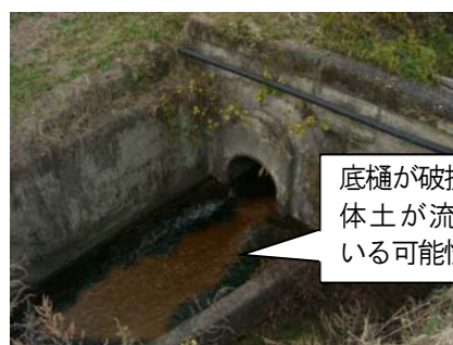
写真11：底樋出口（堤体下流）
