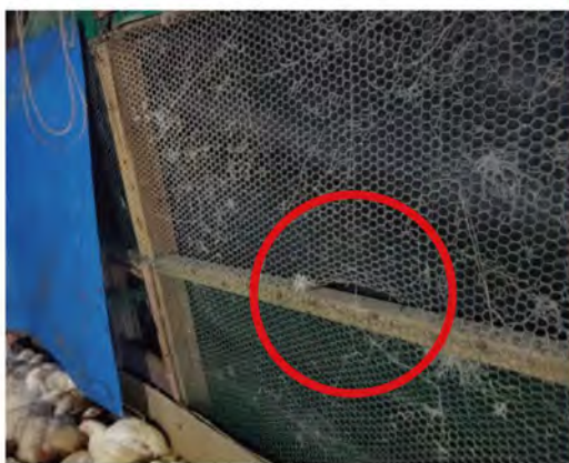
鶏舎側面の網の破損
