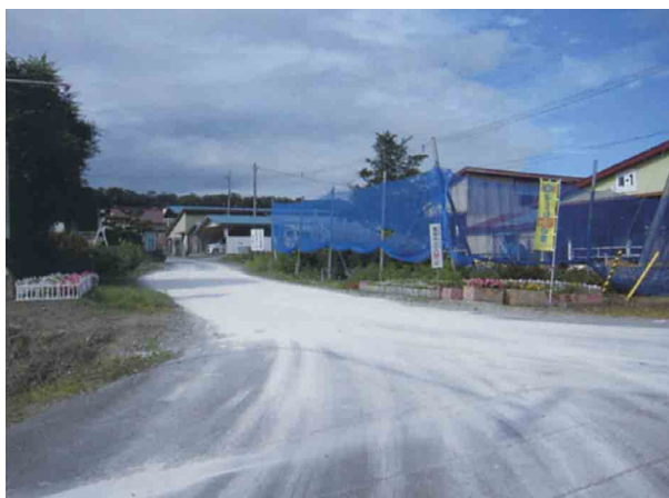
消石灰帯の設置
