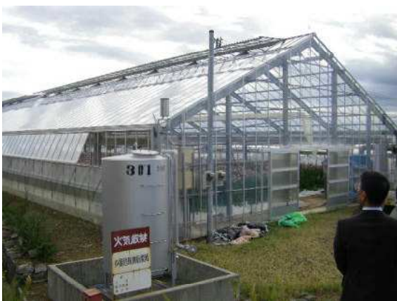
鉄骨温室での現地調査
