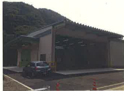
集出荷施設全景
