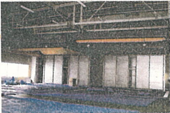
●脱渋施設CTSD(差圧式急速脱渋)方式 46.6t×6室 内2室予冷库兼用
