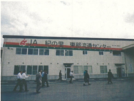
東部流通センター外観
